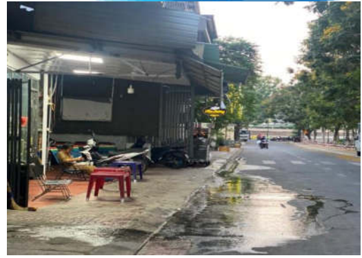
Hình 7.3. Xả nước thải sinh hoạt ra lòng lề đường (Ảnh: Y Thuế)
